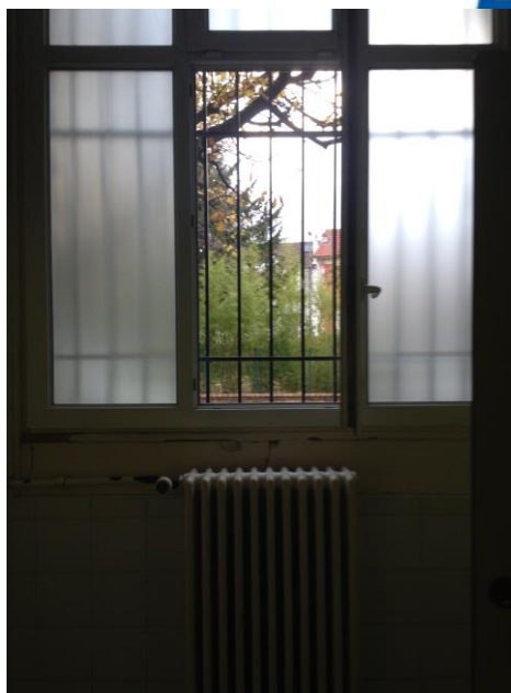
Fenêtre des toilettes ouverte
