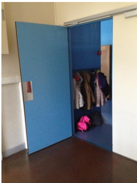
Porte coupe-feu du 1 er étage ouverte
