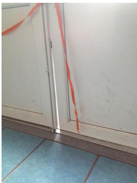
Porte cassée au RDC qui laisse passer l'air.
